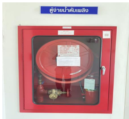
ตู้เก็บสายฉีดน้ำดับเพลิง พร้อมอุปกรณ์
