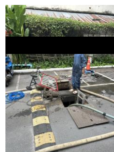
รูปที่ 2-26 สูบไซมันและสูบตะกอนส่วนเกิน 9 กรกฎาคม 2568
