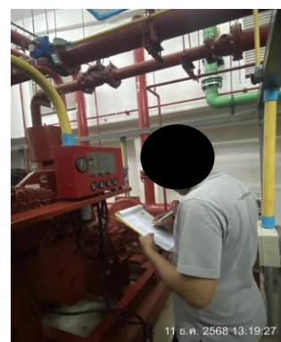
รูปที่ 2-14 เจ้าหน้าที่ PM Fire Pump ประจำสัปดาห์
