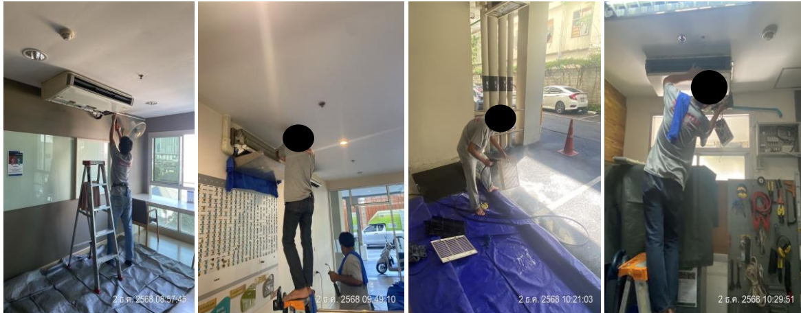
รูปที่ 2-34 ล้างเครื่องปรับอากาศพื้นที่ส่วนกลาง
