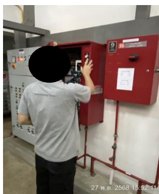
รูปที่ 2-14 เจ้าหน้าที่ PM Fire Pump ประจำสัปดาห์
