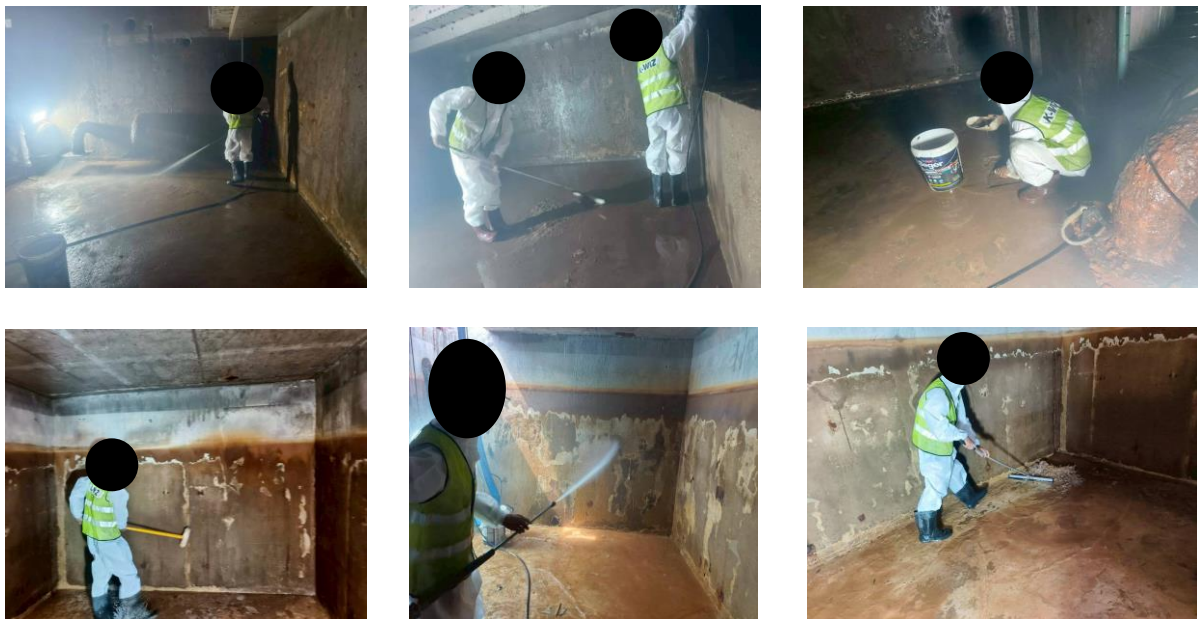
รูปที่ 2-38 ล้างถังเก็บน้ำชั้นใต้ดินและชั้นดาดฟ้า เมื่อวันที่ 11-13 พฤศจิกายน 2568
