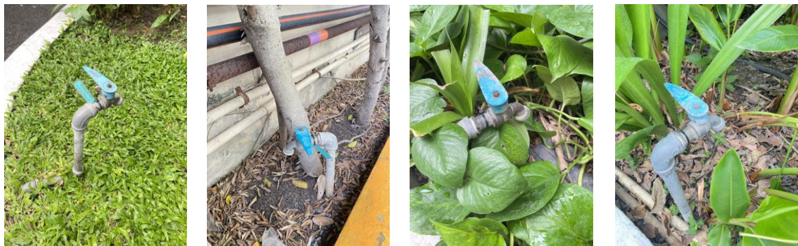
รูปที่ 2-45 ติดตั้งก๊อกน้ำตามจุดต่างๆ และติดป้าย "ก๊อกน้ำสำหรับรดน้ำต้นไม้เท่านั้น"
